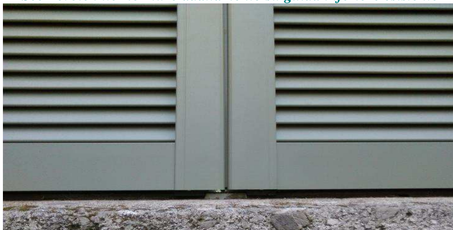
Scorrevole interno muro adattamento su guida inferiore esistente
