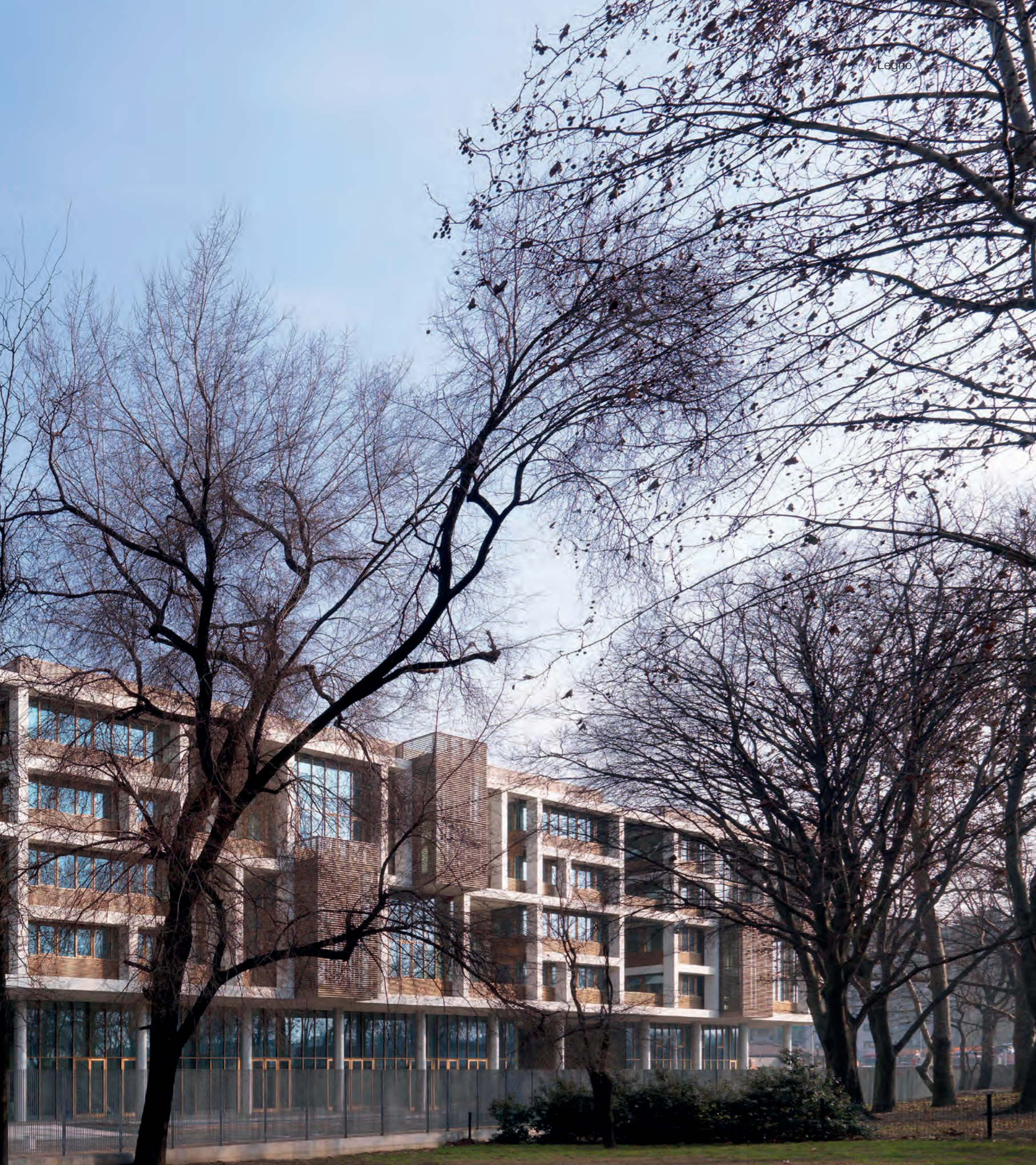
Complesso per uffici Tortona 37 - Milano
