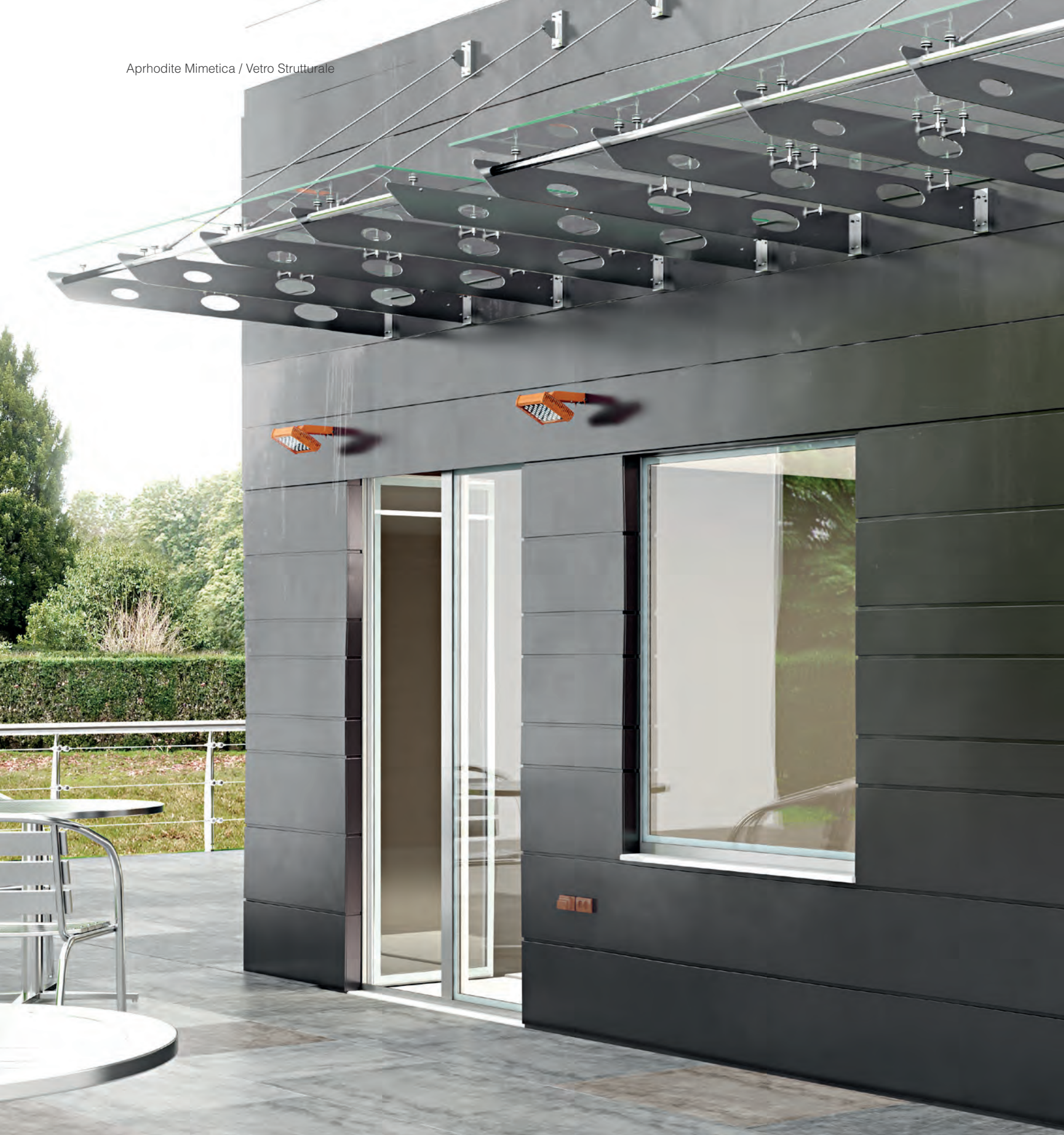
Vista esterna Aphrodite vetro strutturale
